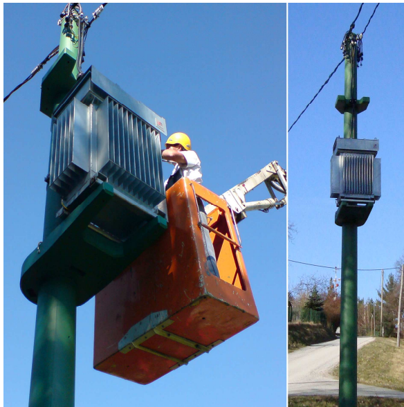
Slika 7: Montaža stabilizatorja na K10 TP.
